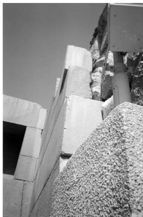
Фото 5. Подгонка гранитной облицовки под выветренные неровности древней кладки.
