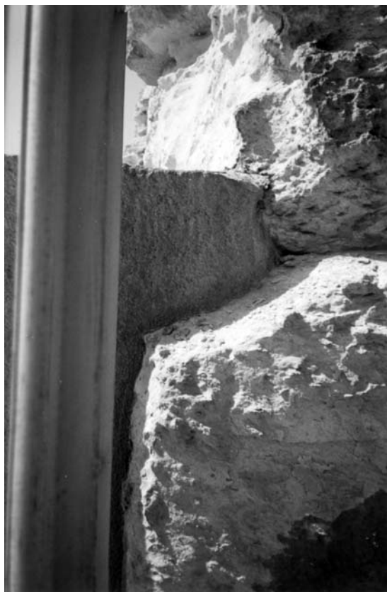
Фото 3. Подгонка гранитной облицовки под выветренные неровности древней кладки.
